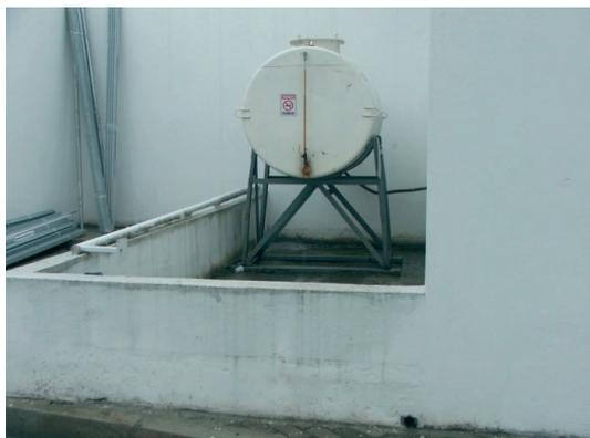
**A figura acima mostra uma bacia de contenção para o reservatório de diesel do grupo gerador**
